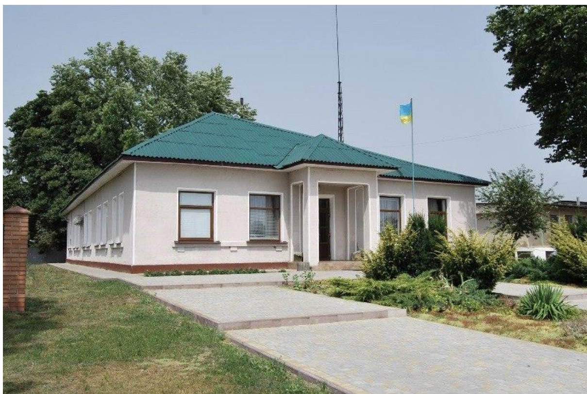
Рис. 2.1. Будівля Філії «Колківське ЛГ» ДП «Ліси України»
