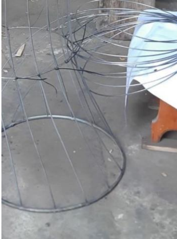
Рисунок 2.12. Формування каркасу та кріплення його до внутрішніх допоміжних кілець
