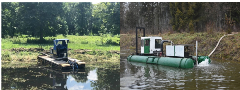
Рис. 4. Працює техніка з розчищення штучних водойм
