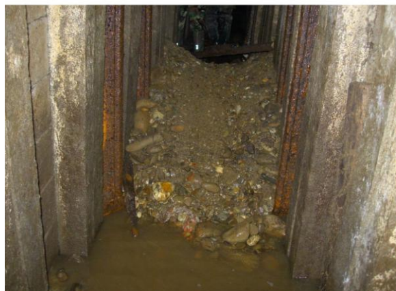
Рис. 4. а) деформація дренажної штольні «Тиса» в районі Чорного Мочара та вивали четвертинних відкладів в ній у вигляді греблі; б) динаміка деформації денної поверхні в районі Чорного Мочара внаслідок розвитку соляного карсту
