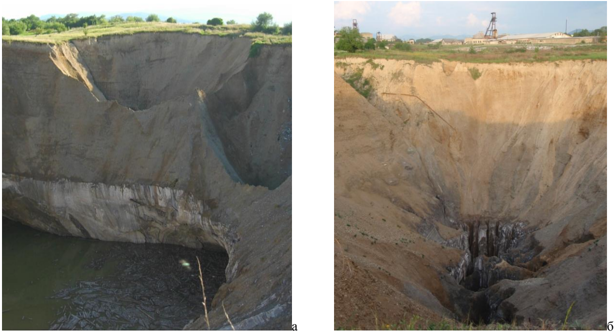
Рис. 6. Найбільші карстові вирви в межах Солотвинського родовища над виробленим простором шахт № 7 (а) та № 8 (б)
