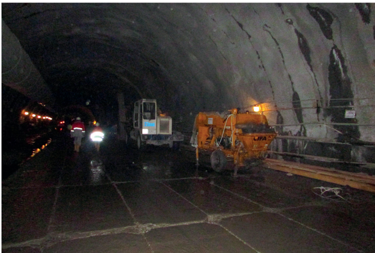
Fig. 6. The New Beskydy Tunnel.
