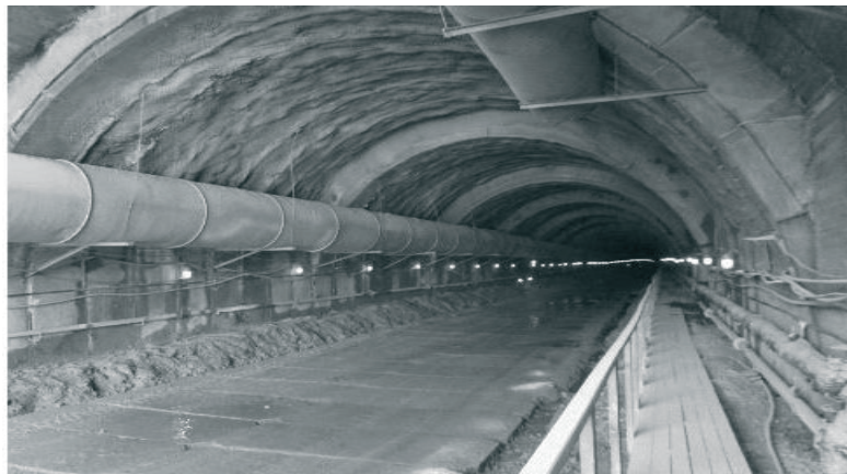
Рис. 1. Загальний вигляд нового Бескидського залізничного тунелю
