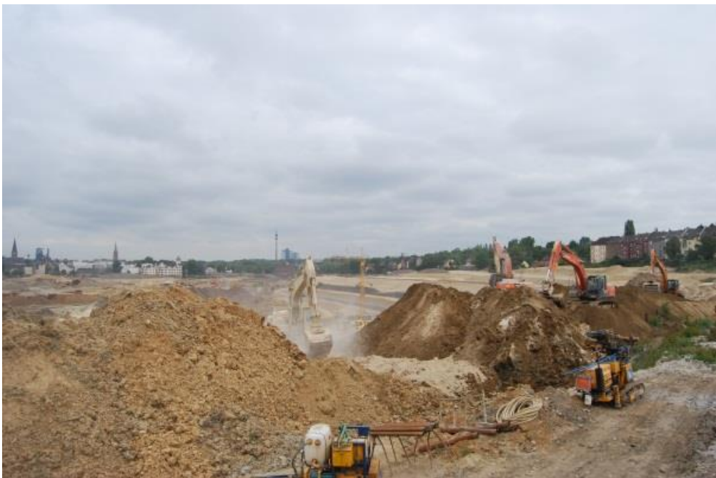
Рис. 4.8. Будівництво штучного озера Фенікс на місці сталеливарного гірничо-металургійного комплексу м. Дортмунд, 2009
