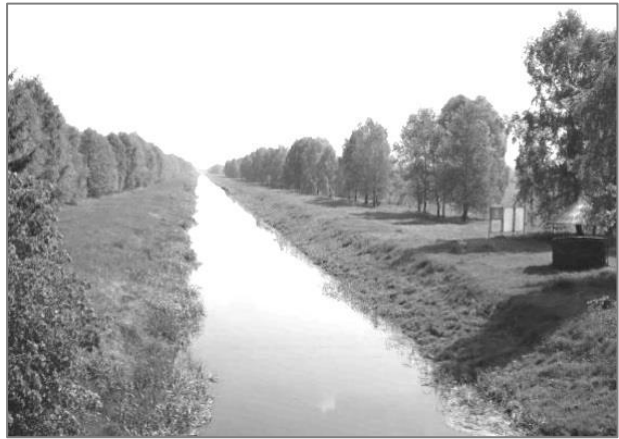
Ф.1.28. Осушення - каналізоване русло верхів'я Прип'яті, Волинська обл., 1975 р.
