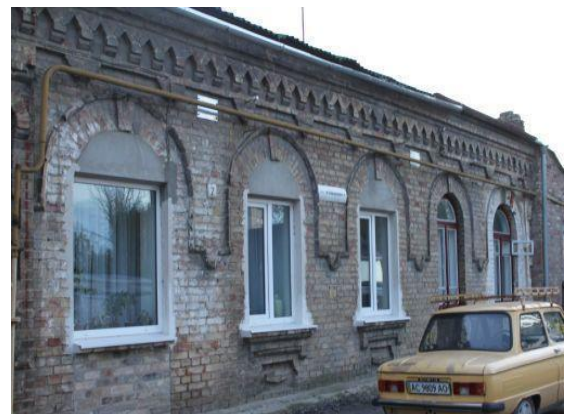
Житловий будинок вул. Романюка, 7
