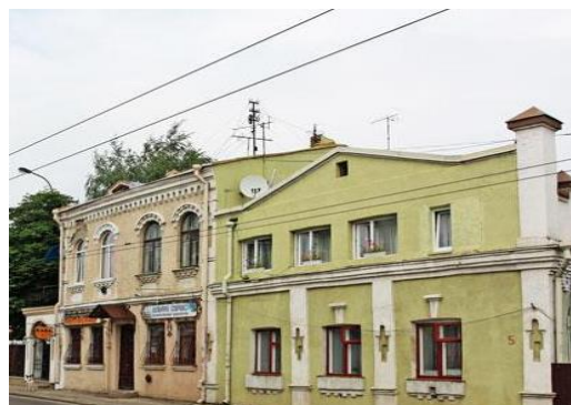
Житловий будинок, вул. Д. Галицького
