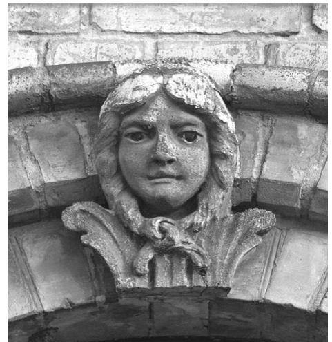
Керамічна маска над вікном будинку буд. на вул. Богдана Хмельницького, 15
